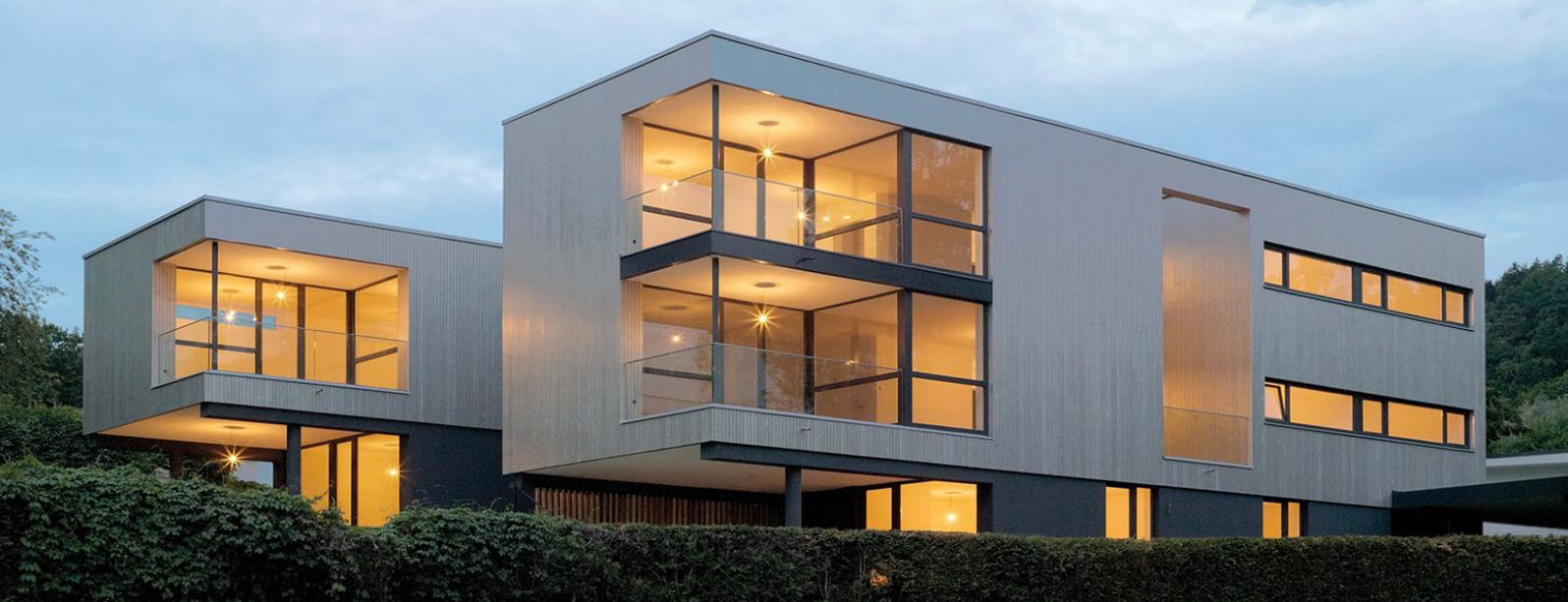
Die industrielle Produktion von Brettsperrholz ermöglicht einen besonders hohen Vorfertigungsgrad, der bis zum Abbund mit eingefrästen Fenster- und Türöffnungen, vorinstallierten Leitungen und endbehandelten Sichtoberflächen reichen kann. Es lassen sich nicht nur großformatige Außen- und Innenwände oder Dach- und Deckenelemente, sondern auch Treppenläufe und Balkonplatten oder lastabtragende Bauteile wie Stürze, Unterzüge und Stützen realisieren.
